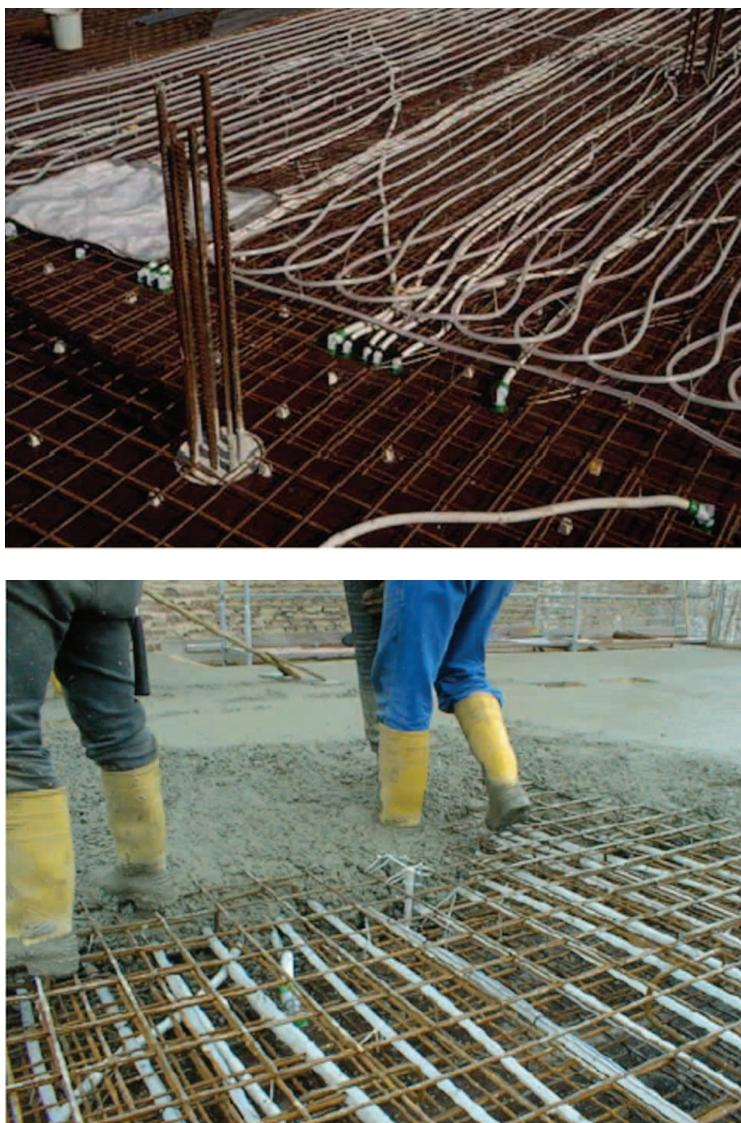
**Şekil 3.** Takviyeli beton tabakasının doğrudan üzerindeki ısıl yönünden etkinleştirilmiş döşeme betonunda borular.
