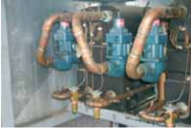
Şekil 3. Kızgınlık alıcı plaka ısı eşanjörleri bölümünün görünüşü.
