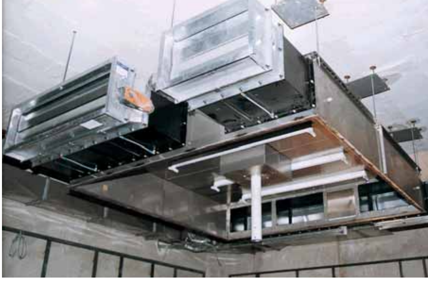
UF ve sbut off damperi montajı
