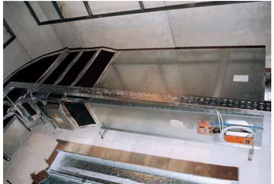
Değişken hava debisi ayar cihazı ve elektrik ısıtıcı montajı
