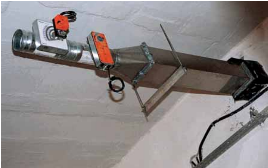
Sabit debi ayar cihazı ve shut off damper montajı
