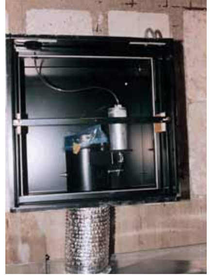
Hepa filtre kutu montajı
