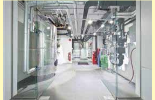
Resim 26. Bina kazan dairesinin genel görünümü
