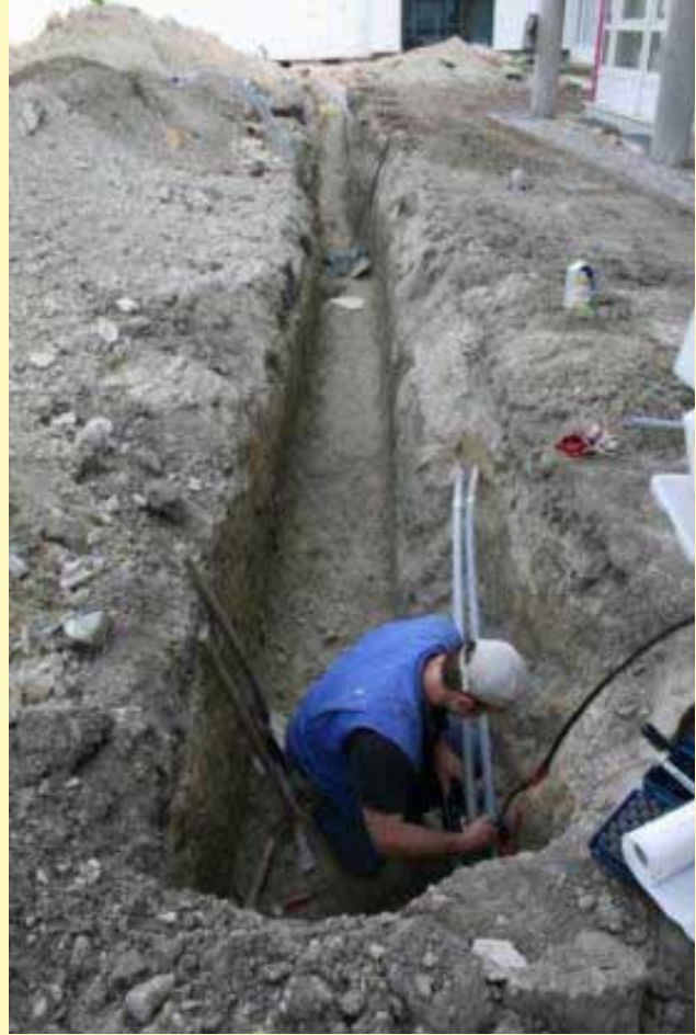
Resim 10. Sondaj - kolektör bağlantı hatlarının tesisi
