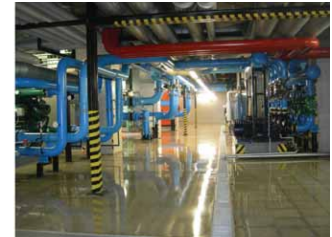
Şekil 4. Sabancı Center binası ve mekanik kattaki kapalı devre.
