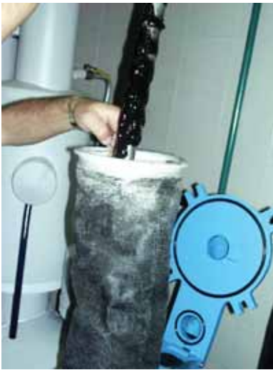
Şekil 3. Torba filtre manyetik rot ve torbasında toplanan metal iyonları ve birikintiler (Sabancı Center, 2006).
